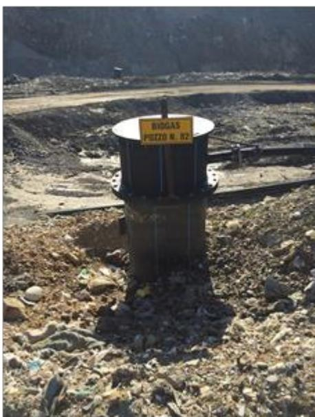
**Figura 8: pozzo di captazione biogas.**
