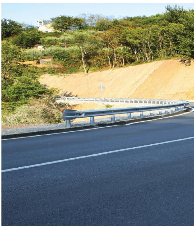
Figura 2: la strada di by-pass della frazione di San Genesio.
