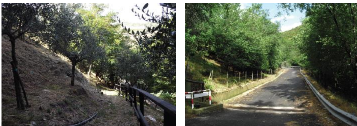
Figura 3: vista della parte “vecchia” della discarica ambientalizzata.
